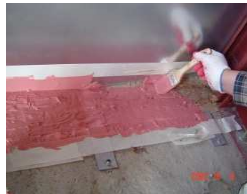
5. CFS-SP WB 시공
