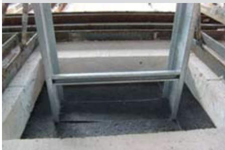
1) CFS-S SIL LD 패드를 개구부와 관통 아이템을 고려하여 알맞게 재단한 후, 관통부에 채워 넣어 고정합니다.
