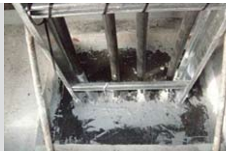
2) 케이블 고정 후 패드와 패드 사이, 패드와 케이블 사이, 패드와 콘크리트 슬라브 사이를 방화실란트를 이용하여 코킹합니다.
